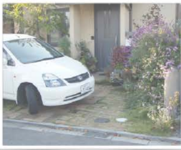
雨水が浸透する駐車場
