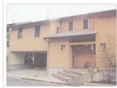
軒下やオープンな駐車場は、雨宿り空間にもなる
