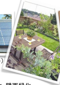
屋上緑化・壁面緑化 (遮熱断熱)
