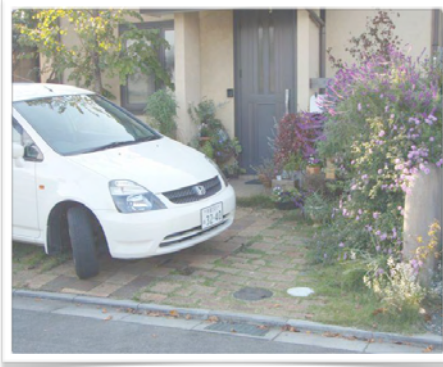
雨水が浸透する駐車場
