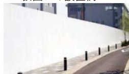
仮囲いの設置例
